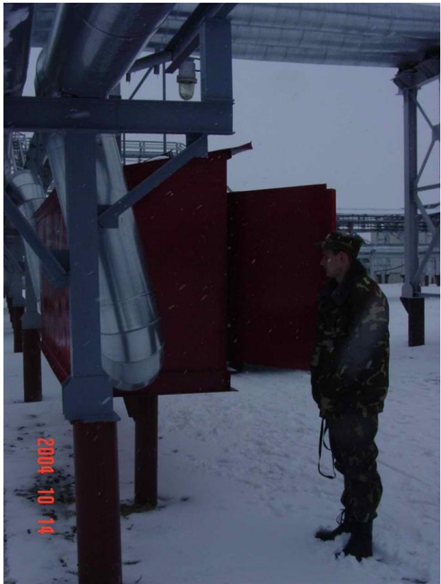
Рис. 10. Надземный пожарный гидрант с размещенной внутри него запорной арматурой
