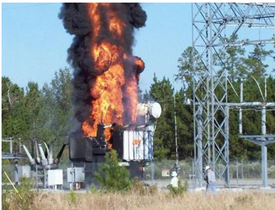
Рис. 1. Пожар трансформатора
