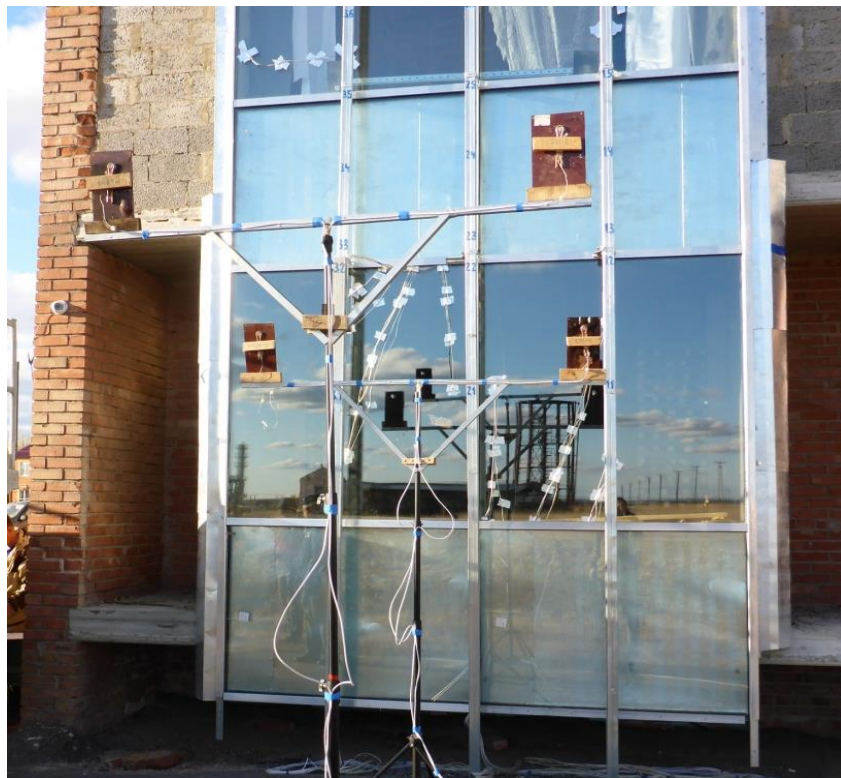
Рис. 1. Общий вид объекта испытаний
